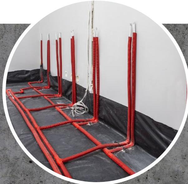
**01** Pred inštaláciou nosnej konštrukcie sa musí vykonáť prívodná inštalácia pre vykurovacie a chladiace panely. Je tiež potrebné naplánovať a položiť ostatné inštalácie, ktoré musia byť vedené za nosnou konštrukciou, napr. elektrinu, kanalizáciu atď.
