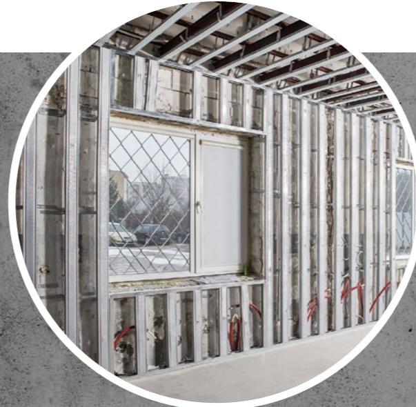
**02** Po položení všetkých potrebných inštalácií je možné pristúpiť k montáži nosnej konštrukcie pre panely (rámu).
