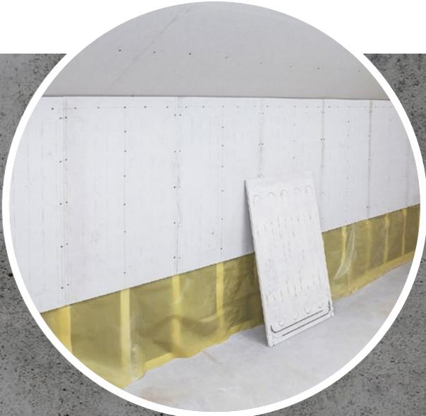
**04** Prilepte vykurovacie a chladiace panely k sebe, aby ste dosiahli monolitickú štruktúru.
