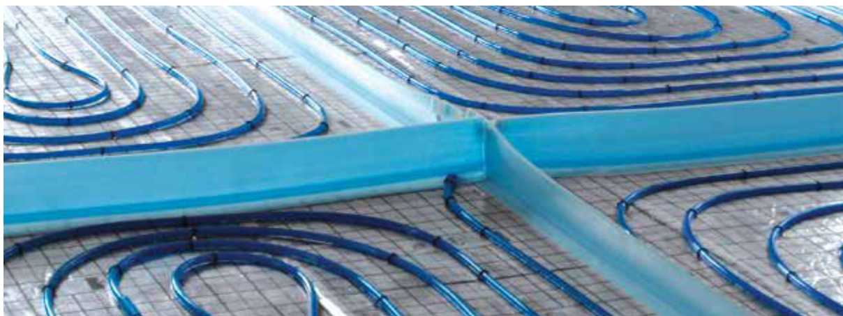
Obr. 14. Rozdelenie vykurovacích polí dilatačnými škárami.
