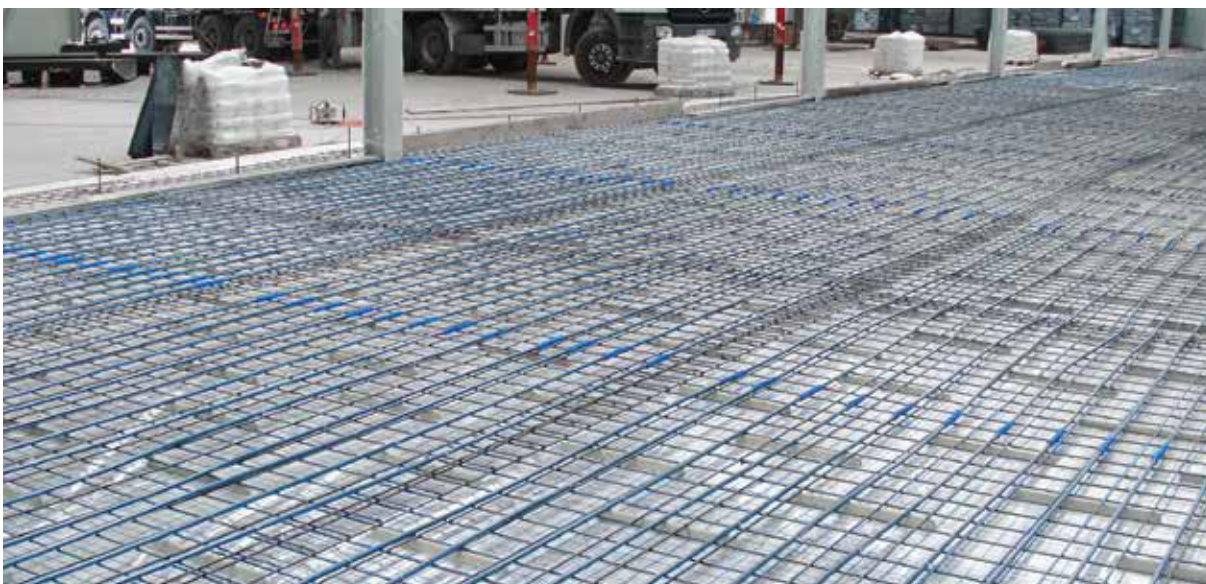
Obr. 4. Inštalácia podlahového kúrenia v sklade pomocou rúr bluePERT a systému KAN-therm NET.
